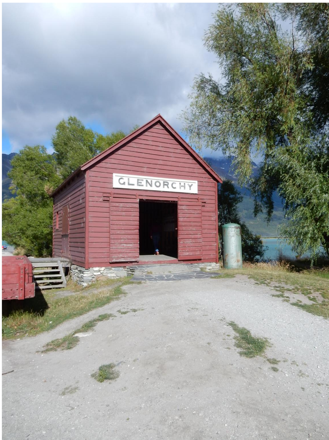
Figure 1: Gjennom dette beskjedne skuret på New Zealand kom halvparten av verdens produksjon av Wolfram under andre verdenskrig.
